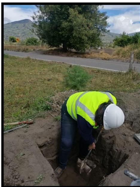
**Figura 23** Pozo a cielo abierto
