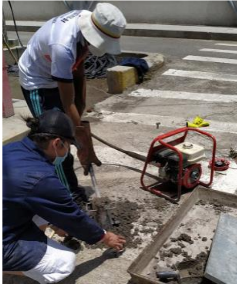
Figura 44. Vibrado del hormigón.
