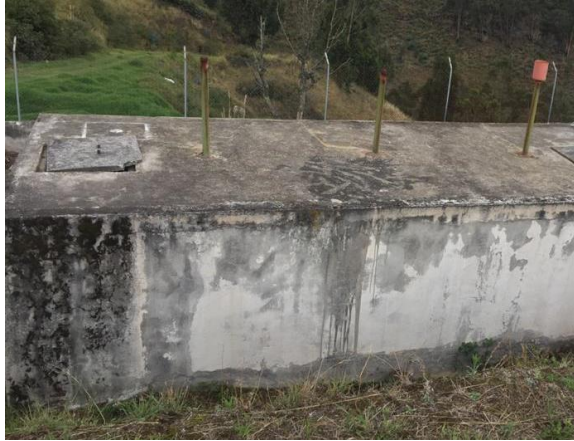
Figura 9. Fosa séptica PTAR
