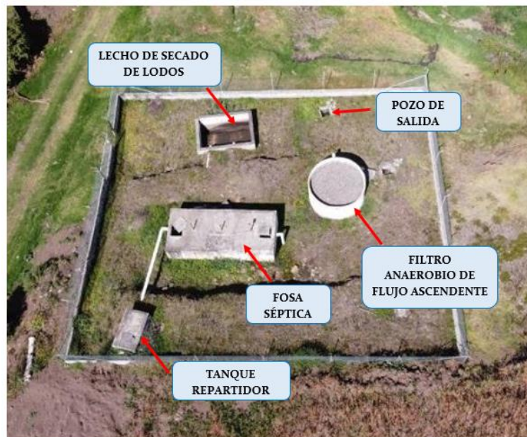
Figura 6. PTAR Comunidad Zona Libre
