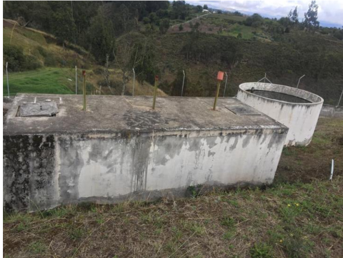
Figura 29. Fosa séptica y FAFA
