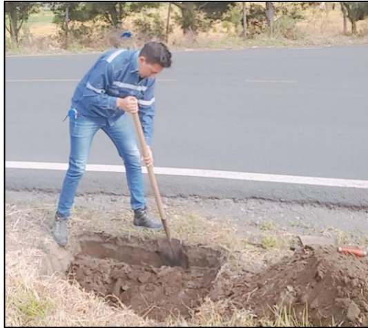
Figura 31. Pozo a cielo abierto
