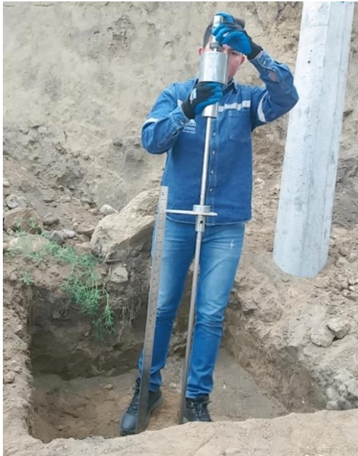
Penetración Dinámica de Cono (DCP)
