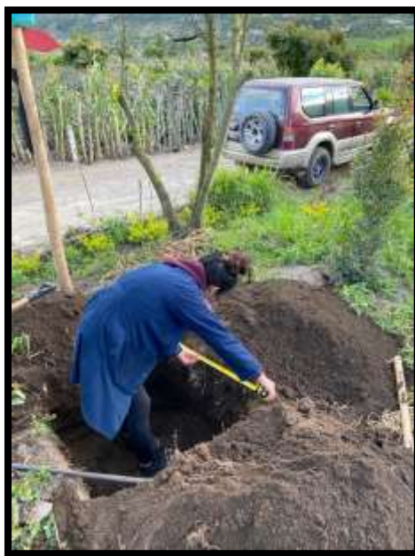
Excavación de la calicata
