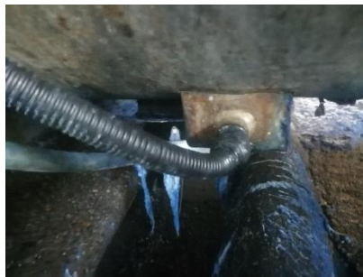
Figura. 22: Sensor de temperatura instalado [Autor].
