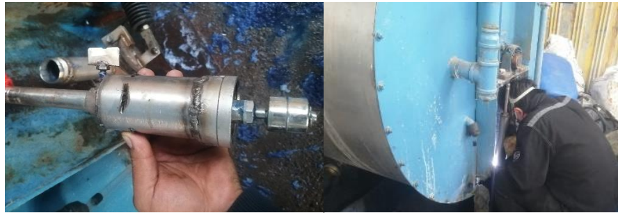
Figura. 23: Sensor de nivel instalado [Autor].
