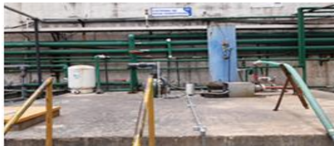
Figura 41: Instalación de tubería para el ruteo de cables.
