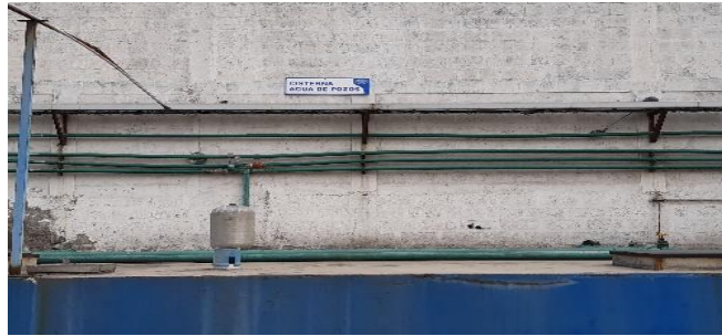
Figura 16: Cisterna de Agua de Pozo.
