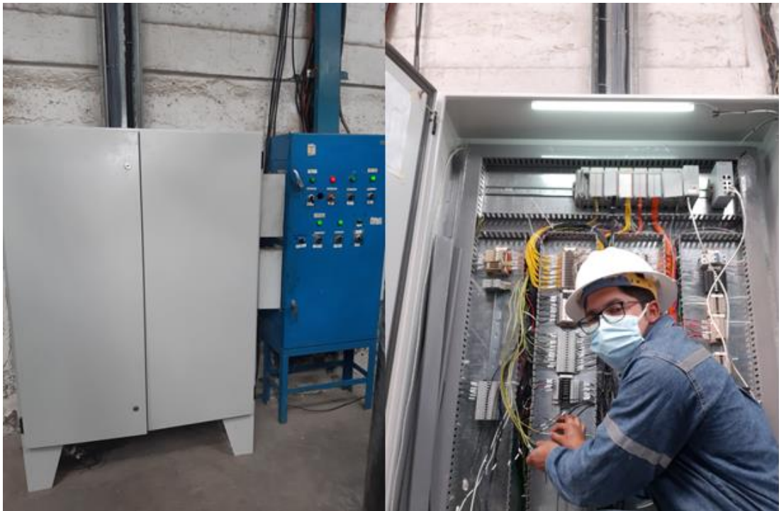
Figura 73: Montaje y conexión tablero de control.
