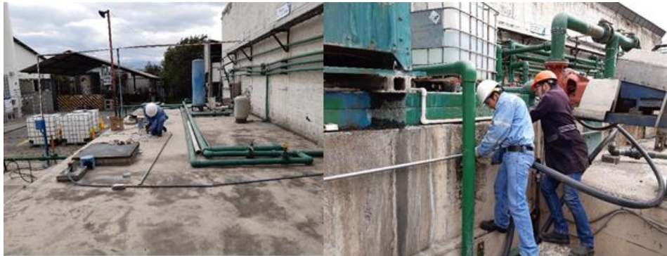
Figura 69: Instalación de tubería en las cisternas.
