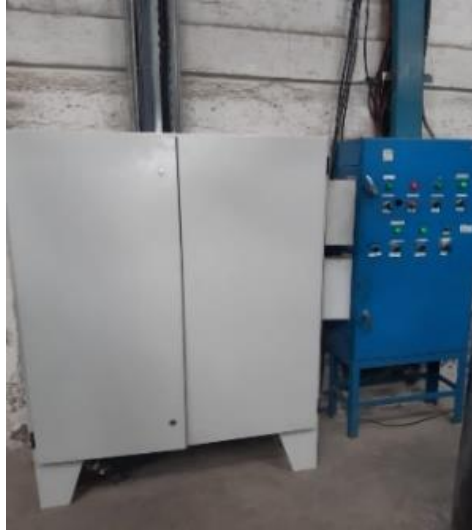
Figura 44: Montaje del tablero de control.
