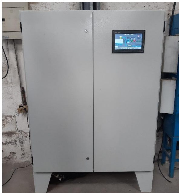
Figura 75: Montaje de pantalla y pruebas de funcionamiento.
