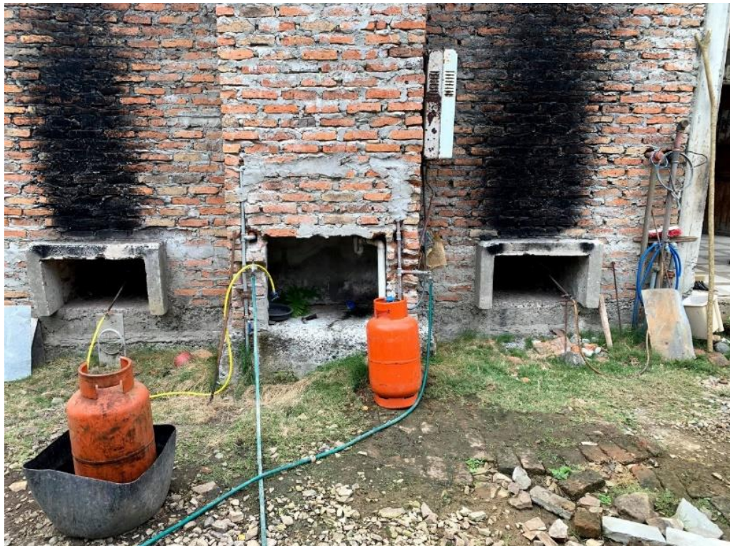
Figura 28 Tanques de gas del sistema de pasteurización.
