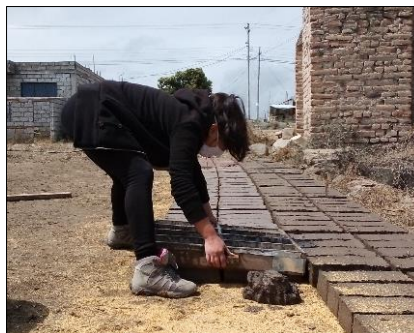
Ilustración 34. Retiro del molde
