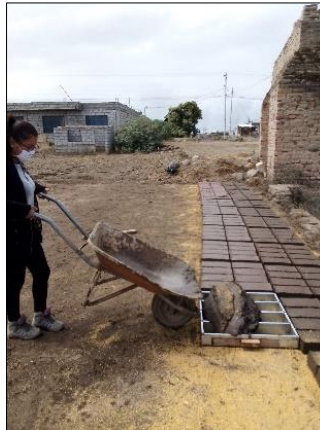
Ilustración 31. Colocación de la mezcla en el molde
