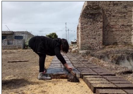
Ilustración 33. Enrasado de la mezcla en el molde
