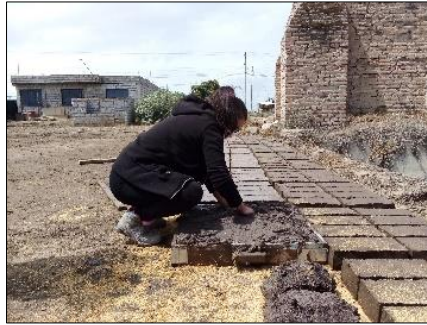
Ilustración 32. Relleno del molde
