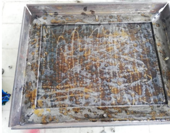
Figura 27. Aplicación de capa de cera para desmoldar.
