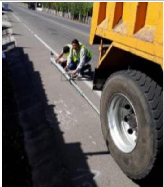
Colocación y armado de la viga Benkelman
