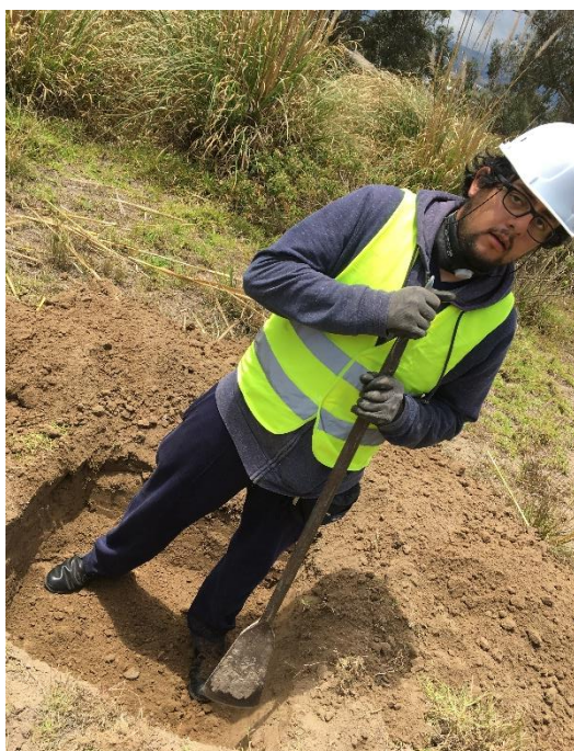
Fig. 18 Pozo a cielo abierto.
