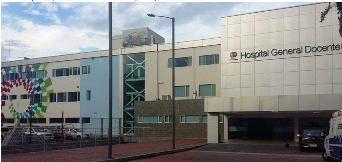
Entrada principal a Consulta Externa y Hospitalización
