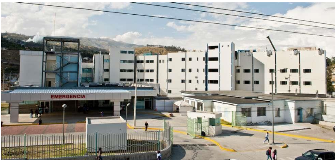
Entrada a Emergencia
