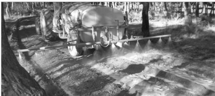
Figura 16: Estabilización de suelos con polímeros
