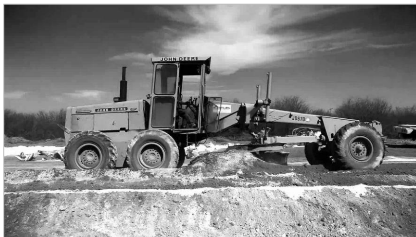
Figura 14: Estabilización de suelos con Cal.
