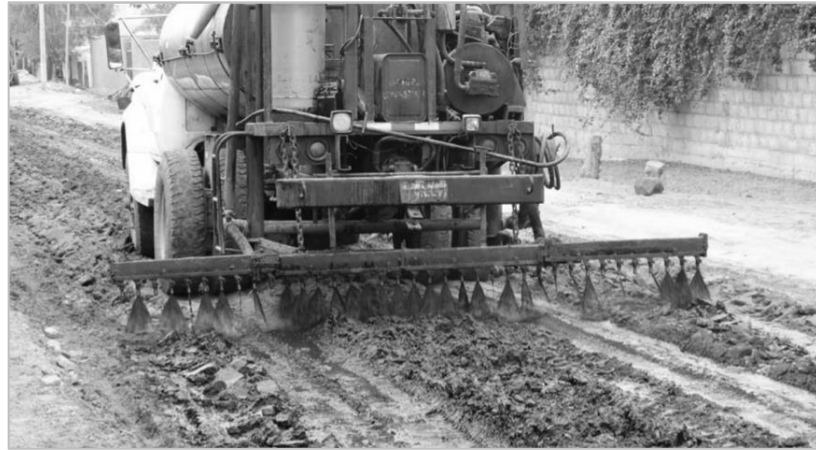
Figura 15: Estabilización de suelos con asfalto líquido.
