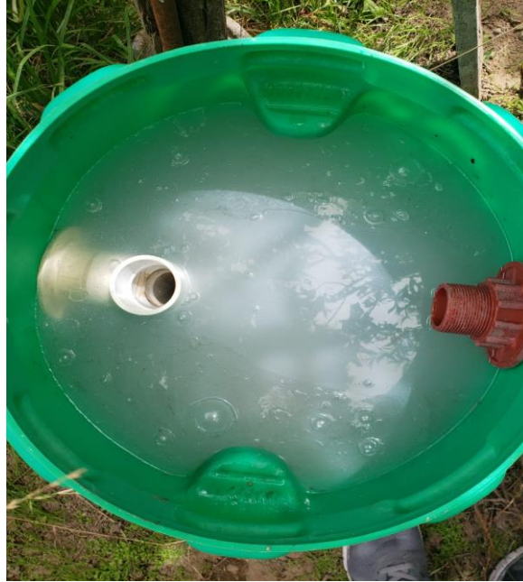
Figura 28. Filtro de flujo rápido ascendente (Alternativa 1)
