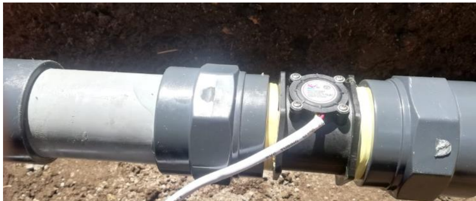
Figura 33 Instalación del sensor de flujo YF-DN50.
