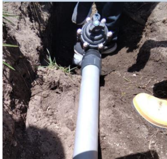
Figura 32. Instalación de la válvula solenoide.
