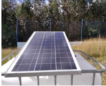
Figura 36. Instalación del panel fotovoltaico Fuente: El investigador
