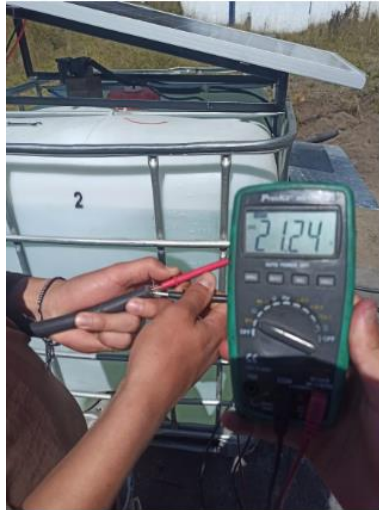
Figura 39. Prueba del panel solar
