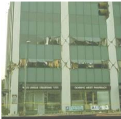
Figura 1: Efecto de columna corta
