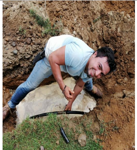
Sondeo de Tuberías
