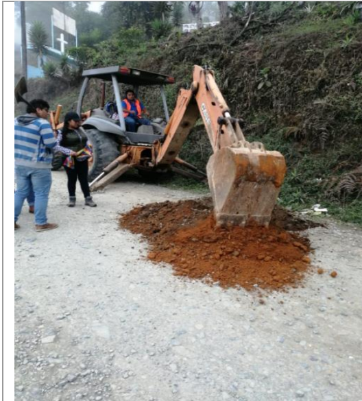
Gallineta para la excavación
