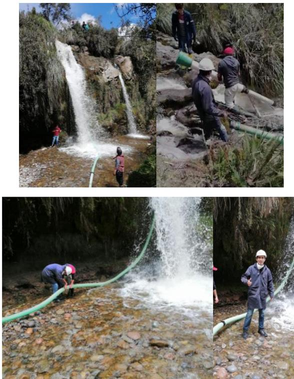
**Figura 49.** Ensamble de tubería y manguera para captación de fluido de turbinas, cascada Cal y Piedra (Mocha - Ambato).
