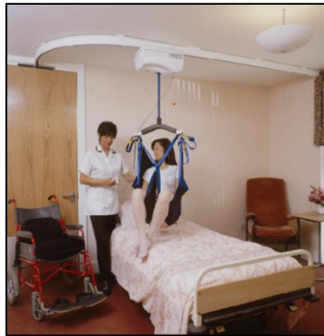
Figura. 19. Grúa de Techo. [19]
