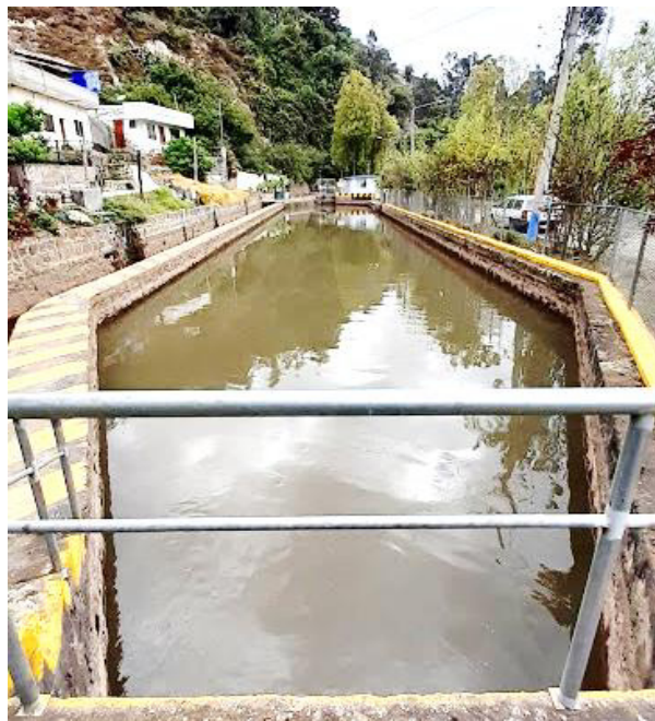
Figura 4. Bocatoma, piscina de sedimentación, [Autor].
