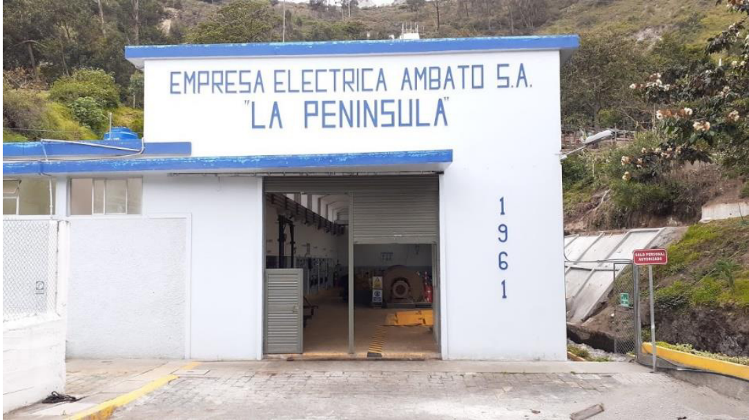
Figura 3. Casa de máquinas de la central hidroeléctrica “La Península” [Autor].
