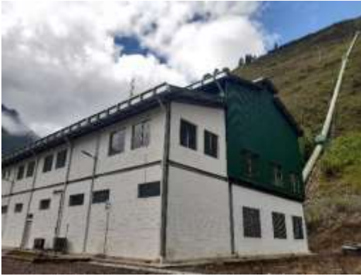
Figura 8: Casa de máquinas y tubería de presión HRVC, Autor.
