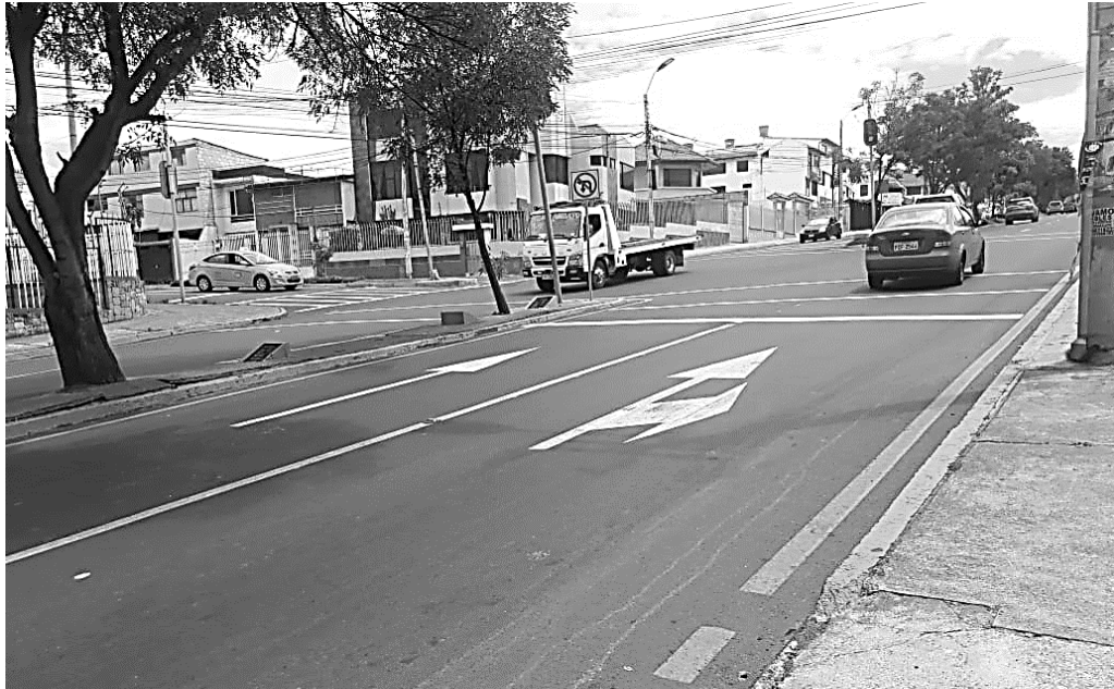
Figura 24: Señalización horizontal sobre pavimento en la vía Manuelita Sáenz
