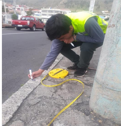
Marcado de distancias a nivel de la acera.
