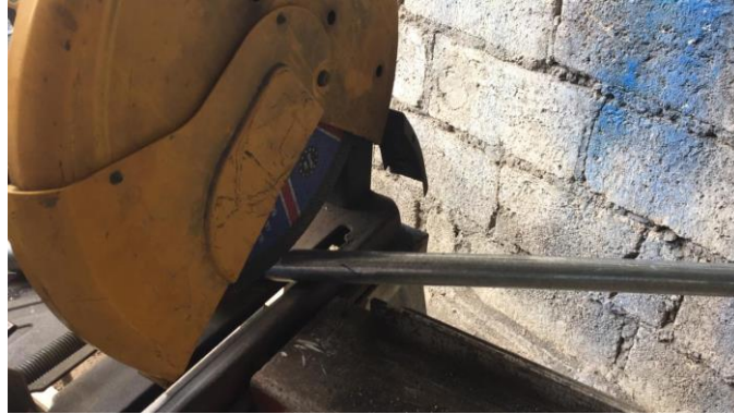
Figura 65: Proceso de corte de la tubería.
