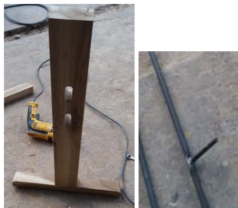
Figura 35: Pata del medio y soldadura de varilla.
