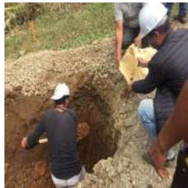
Foto N°12. Extracción de Muestras de Suelo
