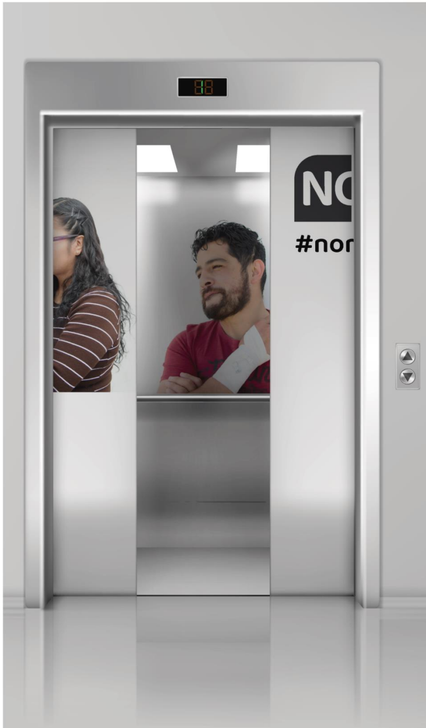
Imagen N.- 55. BTL ascensor 2
