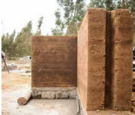
Imagen 30 - Muros de tapial
