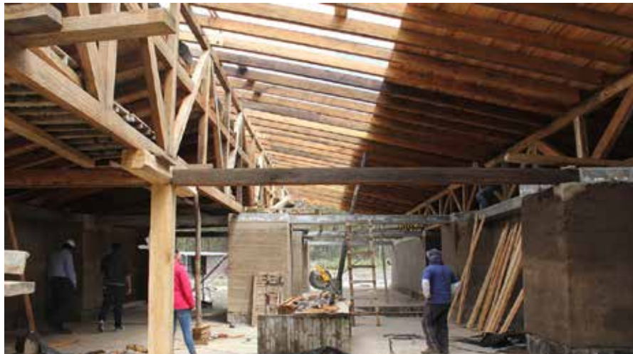
Imagen 35 - Estructura de cubierta
