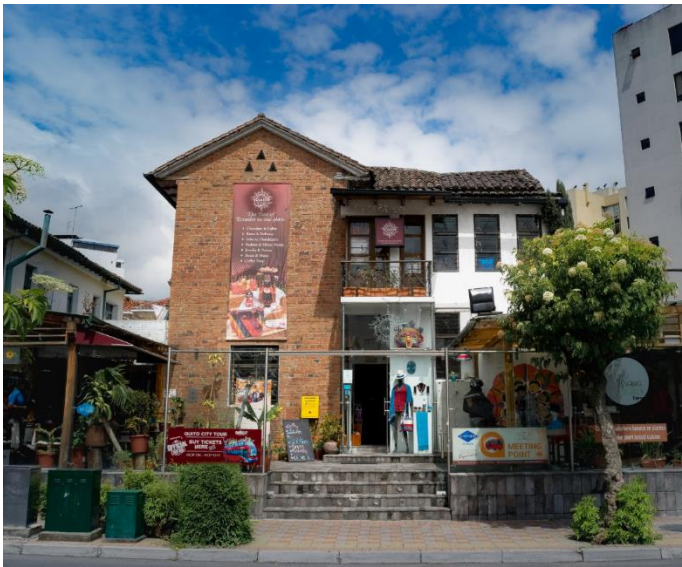
Imagen 14: Exterior de la galería Fuente: Galería Ecuador, 2019
