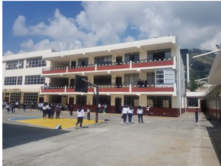
Gráfico 18 Estado actual del edificio de aulas de la Unidad Educativa Santo Domingo de Guzmán
