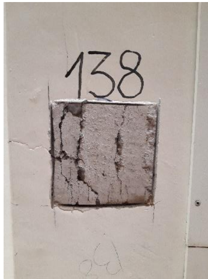
Gráfico 24 Ensayo esclerométrico realizado en columnas
