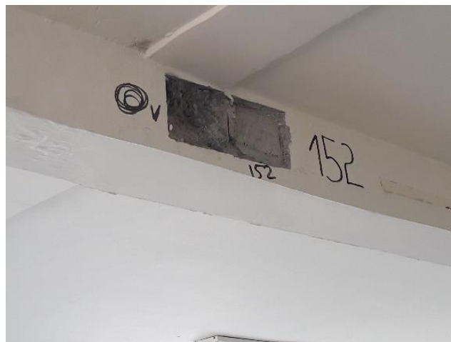
Gráfico 25 Ensayo esclerométrico realizado en vigas
