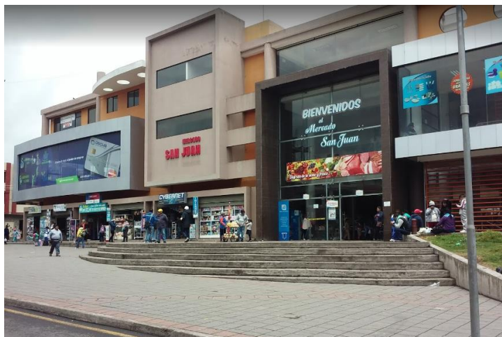
Figura N° 27. Estructura física del Mercado San Juan.
