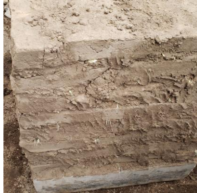
Gráfico 30. Muro de adobe
