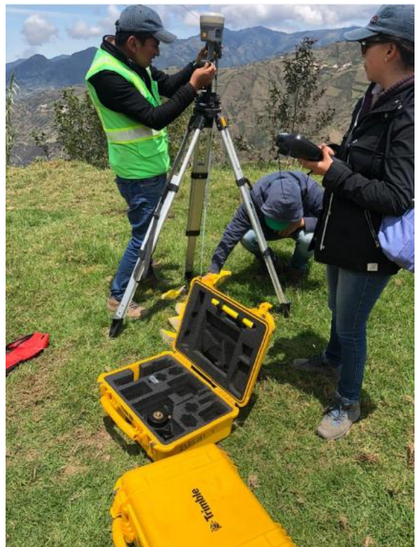
Colocación y fijado de la base del R10 en el trípode
