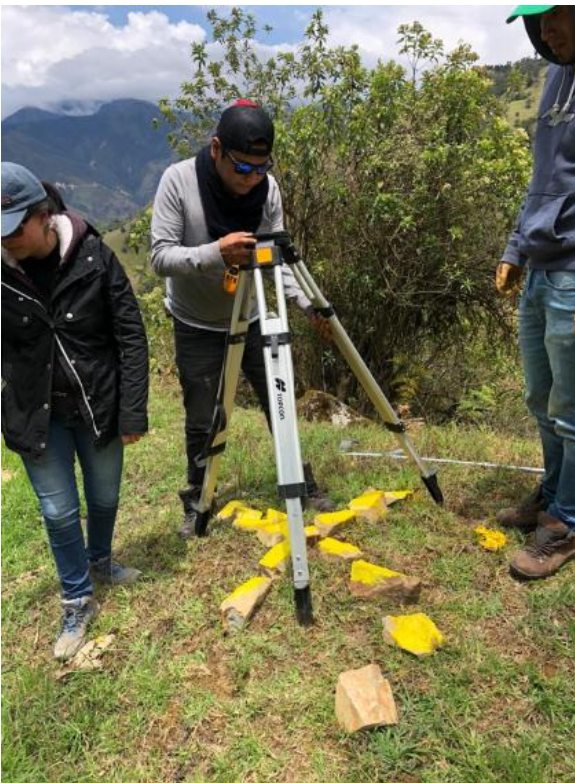
Nivelación del trípode para colocar la base del equipo R10
