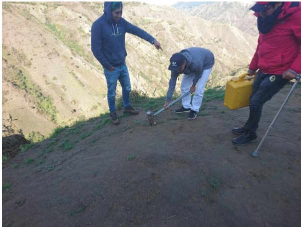
Ubicación de las estacas en los puntos de referencia
