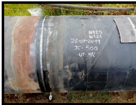
Figura 26. Inspección visual de soldadura.
