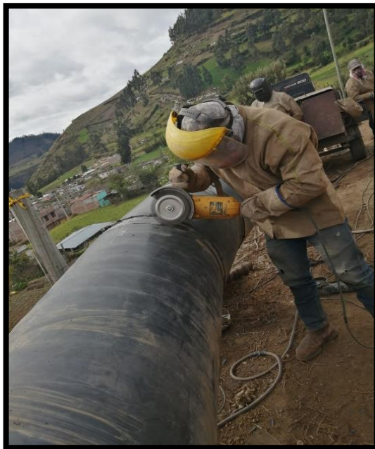
Figura 24. Limpieza de soldadura.
