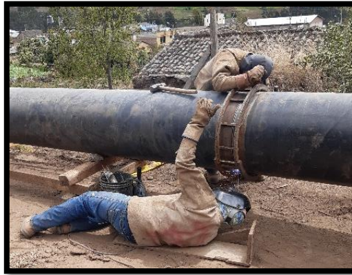
Figura 19. Posición de Soldadura 6G.
