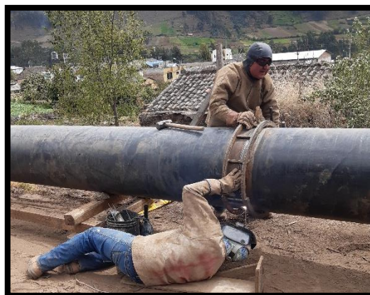
Figura 23. Alineación de tubería.
