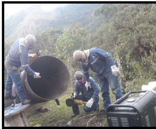
Figura 22. Realización de biseles en tubería.
