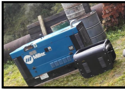
Figura 20. Verificación de Moto-soldadora
