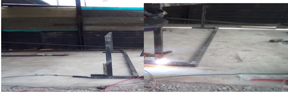
Figura 67. Colocación del pórtico.
