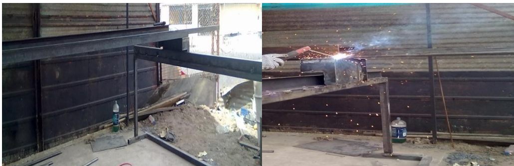
Figura 71. Colocación de la viga UPN100.
