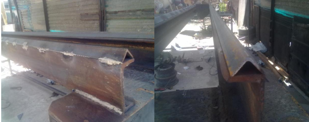
Figura 72. Colocación del ángulo (1/2 x 3/16).
