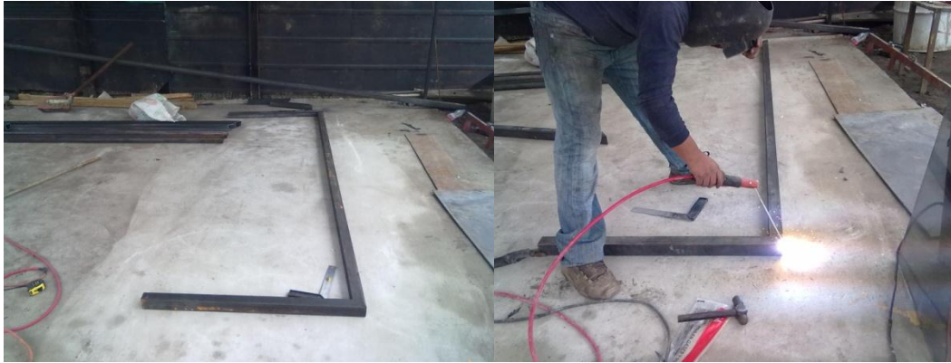
Figura 65. Construcción del pórtico.
