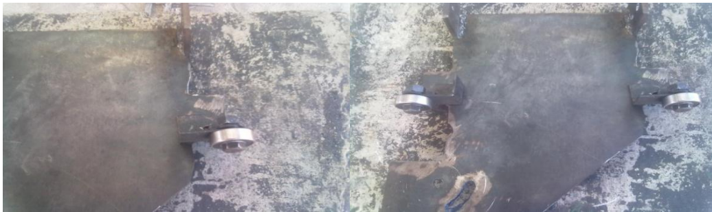
Figura 75. Colocación rodamientos guías.
