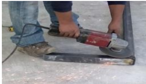
Figura 66. Pulido exceso de soldadura.
