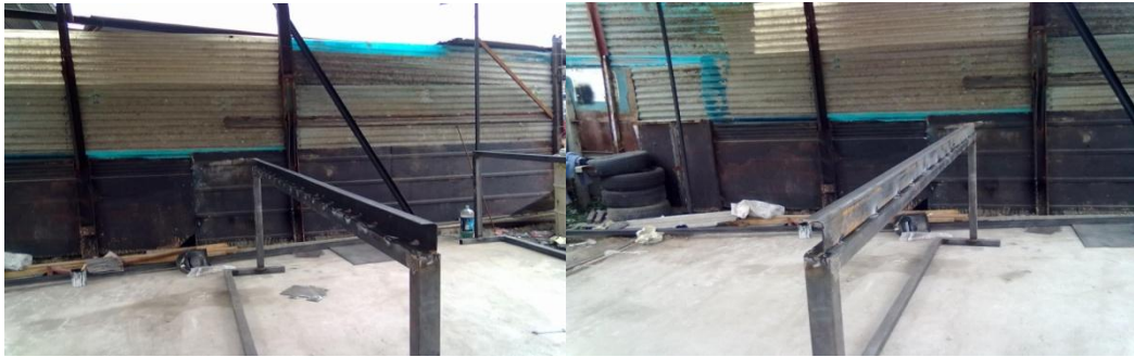
Figura 68. Colocación de la viga U 80x2.
