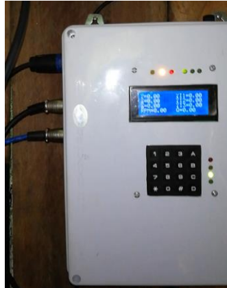
Figura 27. Equipo anclado a la pared, energizado y encendido. [Autor]
