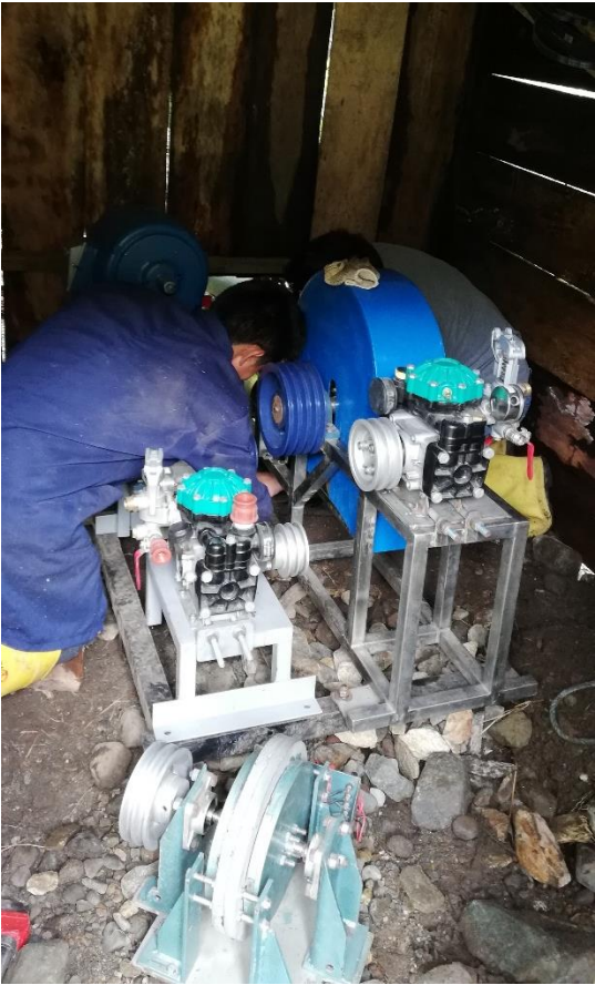
Anclaje de las rotobombas al piso
