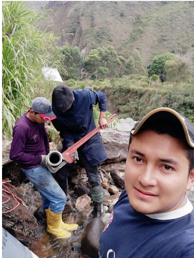
Montaje de unión universal
