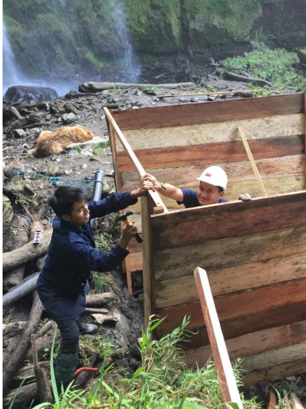
Construcción de la cubierta para las rotobombas
