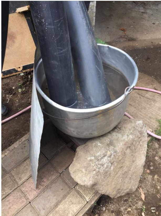
Preparación de manguera para montar los accesorios
