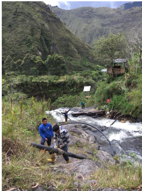
Tendido de la manguera
