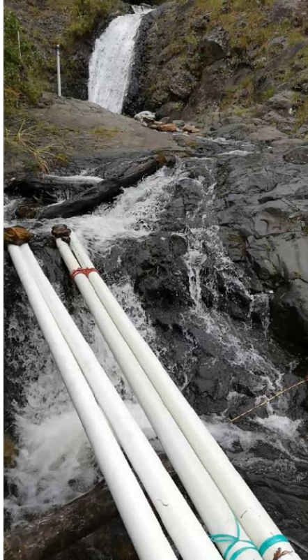
Tubos de alimentación para el tanque
