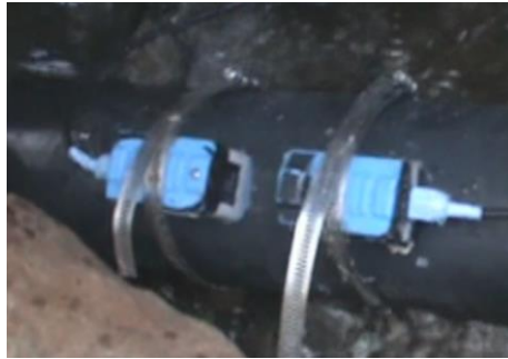
Figura 26. Instalación de sensores ultrasónicos del caudalímetro. [Autor]
