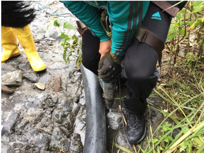
Perforación de la piedra para anclajes
