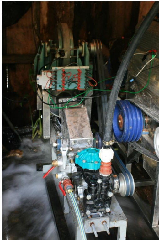
Turbina Michell Banki en funcionamiento
