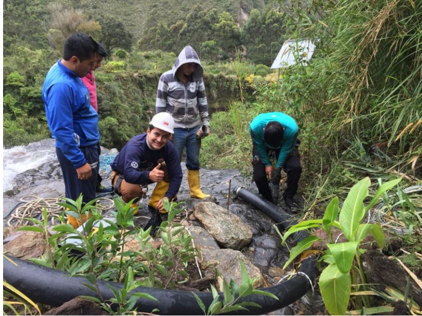
Anclaje de la manguera
