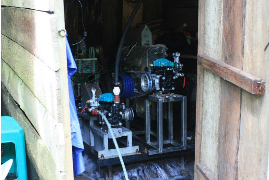
Máquinas dentro de la caseta
