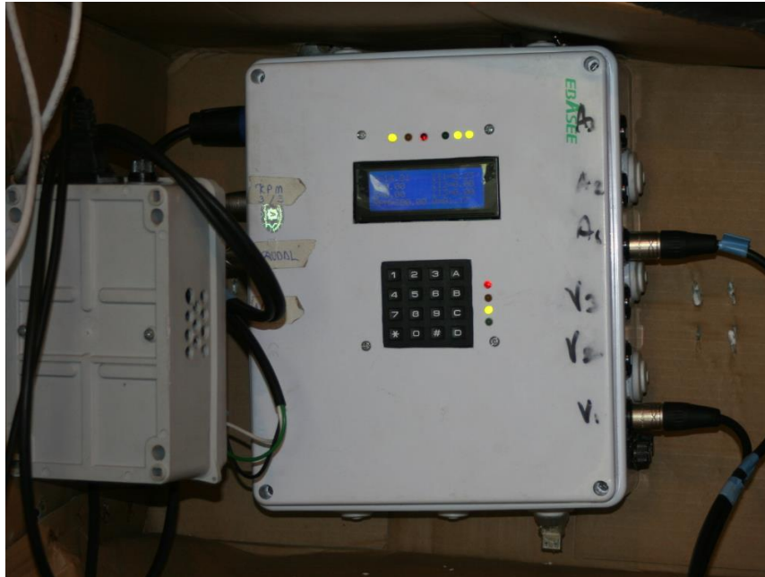
Instalación del equipo de medición
