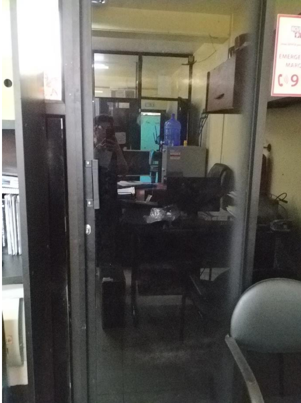
Fig. 25 Ingreso al data center
