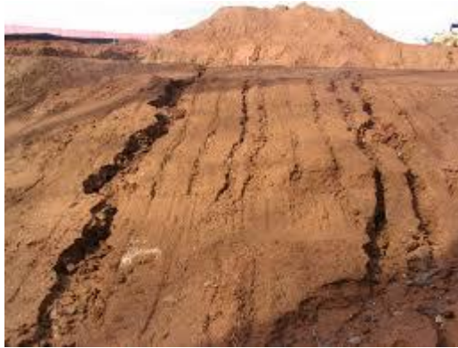
Gráfico No 9: Falla por erosión laminar Fuente: Suárez, Jaime, Análisis Geotécnico
