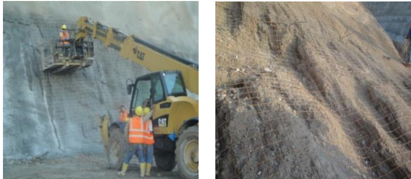
Gráfico No 27: Colocación de malla electrosoldada Fuente: Rafa López
