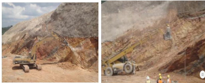
Gráfico No 23 : Perfilación del Talud y Limpieza con chorros de agua. Fuente: Rafa López
