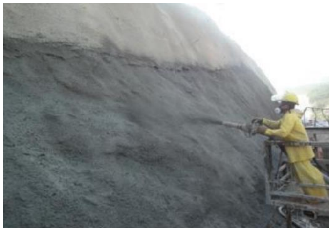
Gráfico No 28: Segunda capa de concreto. Fuente: Rafa López
