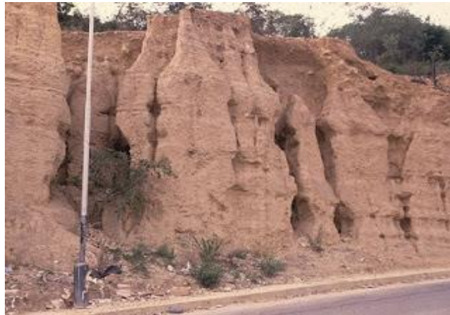
Grafico No 11: Falla interna o pinping Fuente: Suárez, Jaime, Análisis Geotécnico
