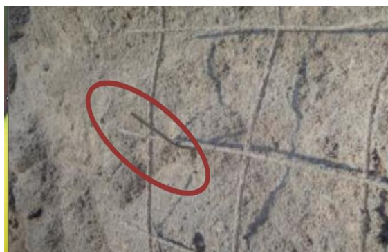
Gráfico No 24: Clavijas para asegurar la malla de refuerzo. Fuente: Rafa López
