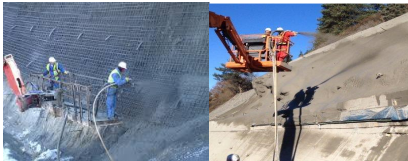
Gráfico No. 16: Hormigón Lanzado, colocación
