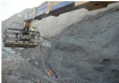
Gráfico No 26: Primera capa de concreto Fuente: Rafa López
