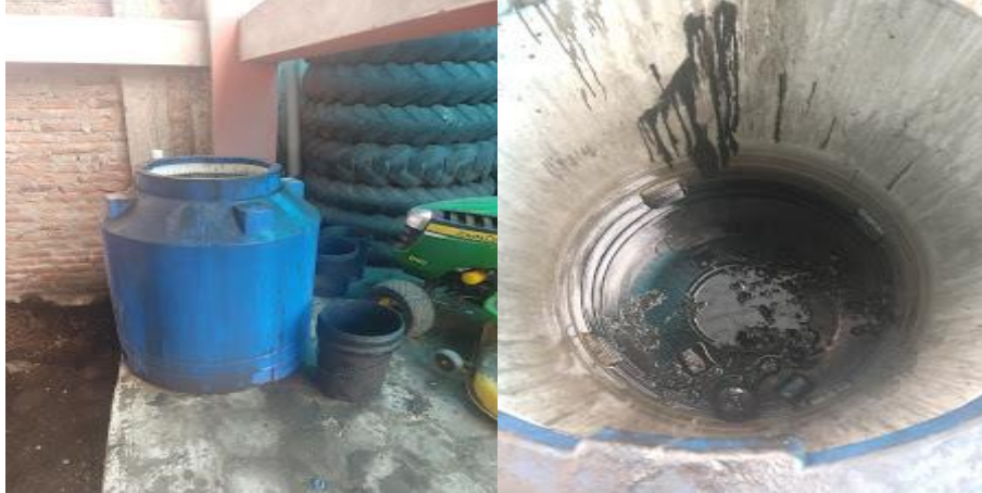
Figura 13. Depósitos de Aceites Usados Y Filtros. Fuente: Autor
