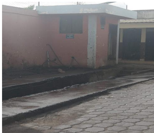
Figura 16. Cuarto de Bombeo. Fuente: Autor
