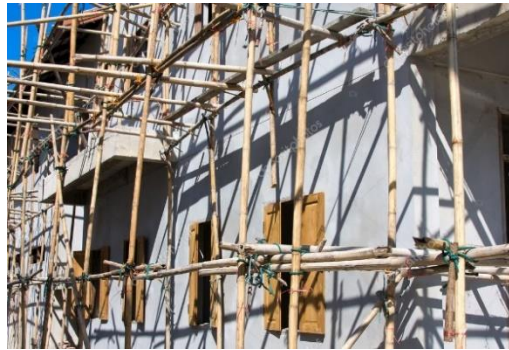
Figura 5. Andamios de madera
