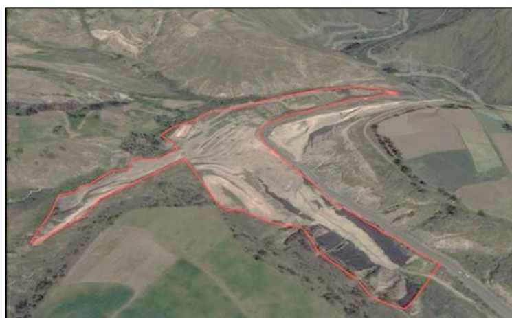
Gráfico 8: Ubicación del relleno sanitario
