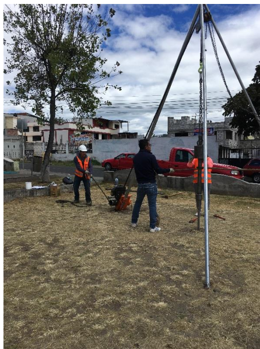
Fotografía 4. Hincando el martinete
