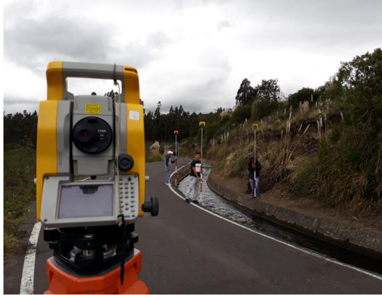
1. Levantamiento topográfico con estación total.
