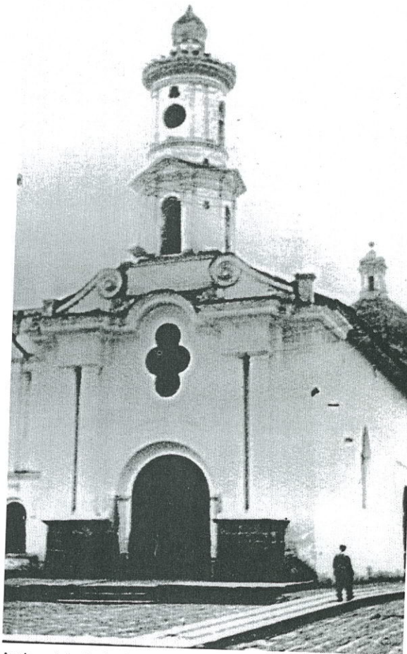
Antigua iglesia de Santo Domingo, la cual se derrumbó con el terremoto del 49, calles Cevallos y Montalvo. Foto José Paredes.
