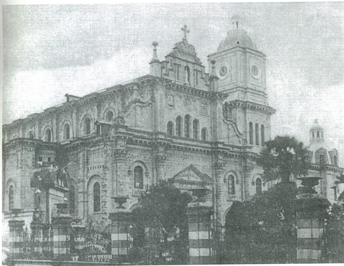
Iglesia de La Matriz frente al parque Montalvo. La iglesia fue terminada en 1925 y en 1949 se derrumbó su nave central a causa del terremoto.
