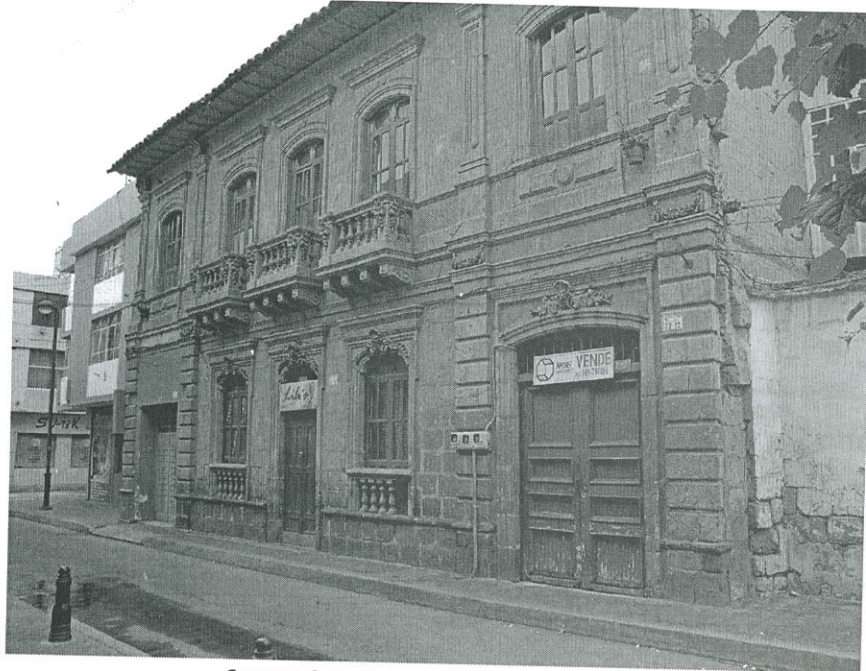
Casa con fachada de piedra que perteneció al Dr. Víctor Manuel Garcés, sobre la calle Quito, entre Bolívar y Sucre. Foto Adolfo Holguín.
