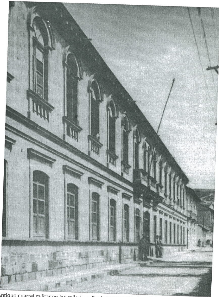
Antiguo cuartel militar en las calle Juan Benigno Vela y Mariano Egúez, el que se destruyó parcialmente con el terremoto del 49. Foto José Paredes.
