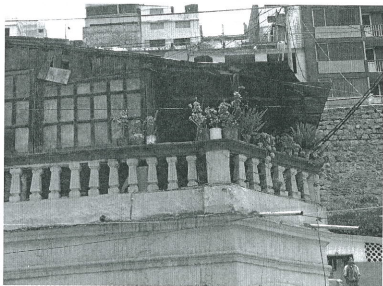
Detalle de la casa en la calle Montalvo y Olmedo. Foto Adolfo Holguín.
