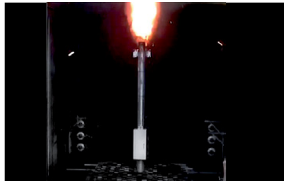
PRUEBA DE CONTENCIÓN DE FALLA POR ARCO
