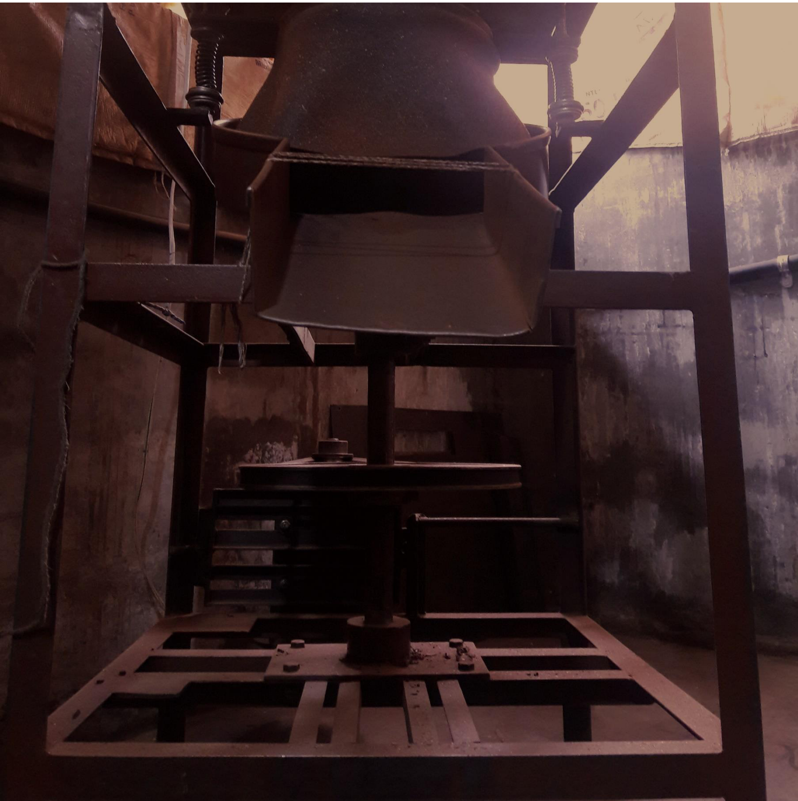
Imagen N° 34: Molino eléctrico en desuso Fuente: La autora
