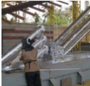
Imagen 5. Extracción elementos galvanizados.
