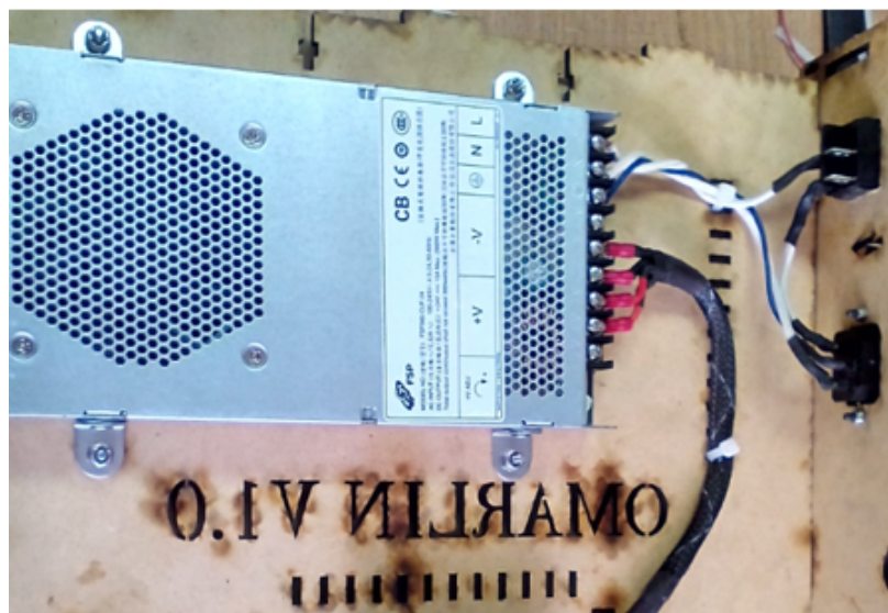
Figura 4.80: Fuente puesta y cableada en la base. Fuente: El autor
