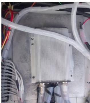
Figura 4. 11 Implementación de la placa de aluminio debajo del controlador
