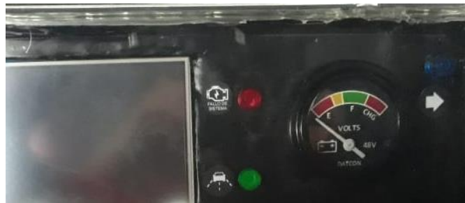
Figura 4. 20 Indicador del estado de carga de las baterías
