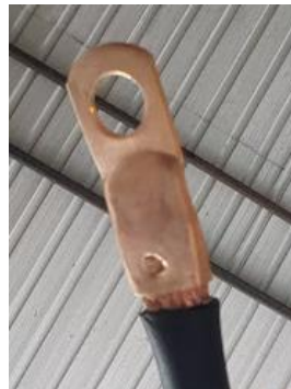
Figura 4. 16 Instalación de terminales de cobre en los cables de alto rendimiento
