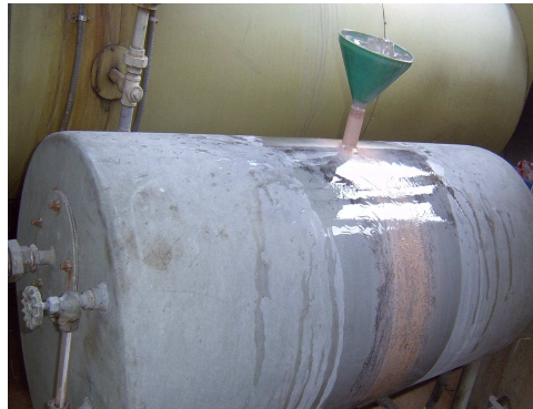
Fig. 14 Alimentador de agua
